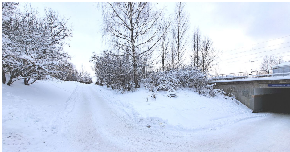
Asemapolun pohjoispää ja radan alikulutunneli keskustaan
